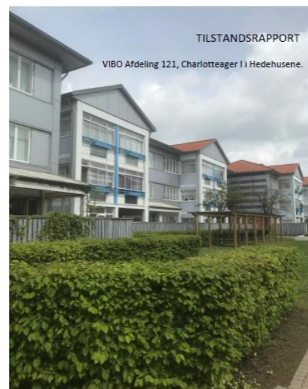
TILSTANDSRAPPORT VIBO Afdeling 121, Charlotteager i Hedehusene. 26.07.2019/KG TEYTAUD Rådgivende Ingeniører A/S C.F. Richs Vej 107A, 2000 Frederiksberg Telefon 38 88 78 09 Fax 38 88 72 02 www.t2.dk
